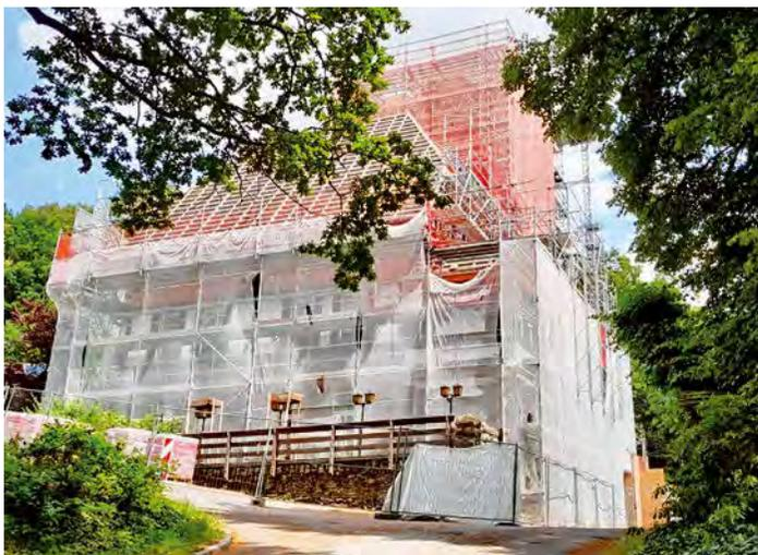
Die Sanierung des Berggasthauses ist in vier Bauabschnitte aufgeteilt: Dach/Fassade – Gaststätte – Betriebswohnung im Dachgeschoss – Saal in der ersten Etage. Nur so kann etappenweise das jahrelang leerstehende Haus saniert werden. Die Baugenehmigung liegt vor und zurzeit sind die Zimmerleute und Dachdecker im Dachstuhl und auf den vielen Dachflächen aktiv.
