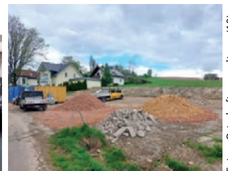
Herstellung eines Wendehammers an der Zechenstraße auf Wüstenbrander Flur
