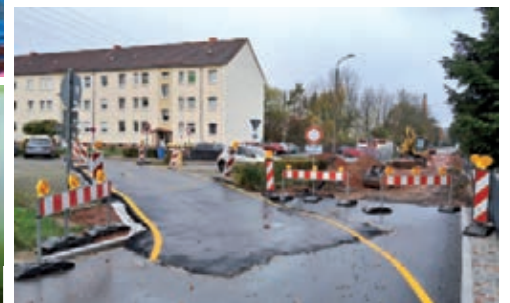
Grundhafte Straßensanierung Landgraben
