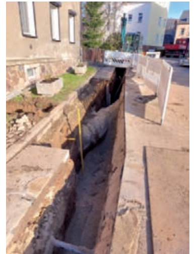
Erneuerung der Gasleitungen auf der Hermann-Schubert-Straße
