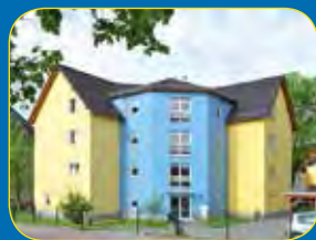
SERVICE-WOHNEN „AM SCHÜTZENHAUS“
