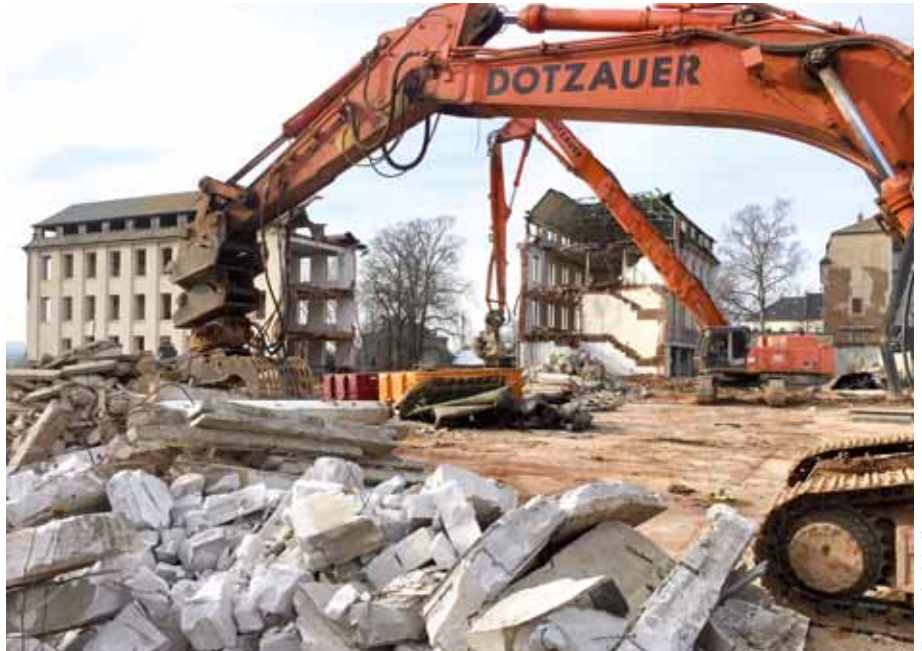
Im Februar haben die Abrissarbeiten an der ehemaligen Clauß-Fabrik begonnen. Bis Mitte April etwa soll das einstige VEB Trikotagenwerk aus dem Stadtbild verschwunden sein.
